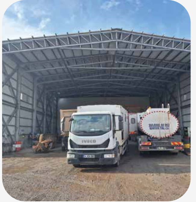
HATAY ES GRUP HANGAR CEPHE VE ÇATI MONTAJI
