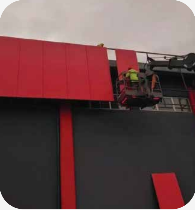
BURSA SALÇA FABRİKASI CEPHE KAPLAMA MONTAJI
