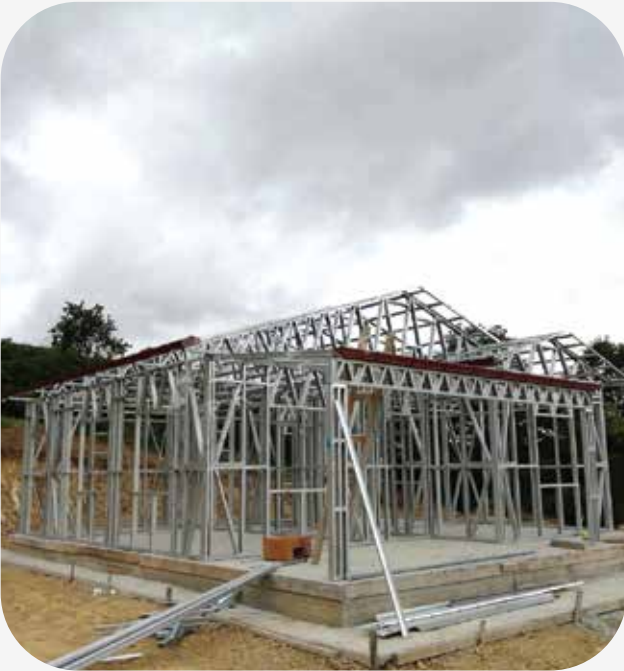
HATAY BELEN PREFABRİK KONUT PROJESİ
