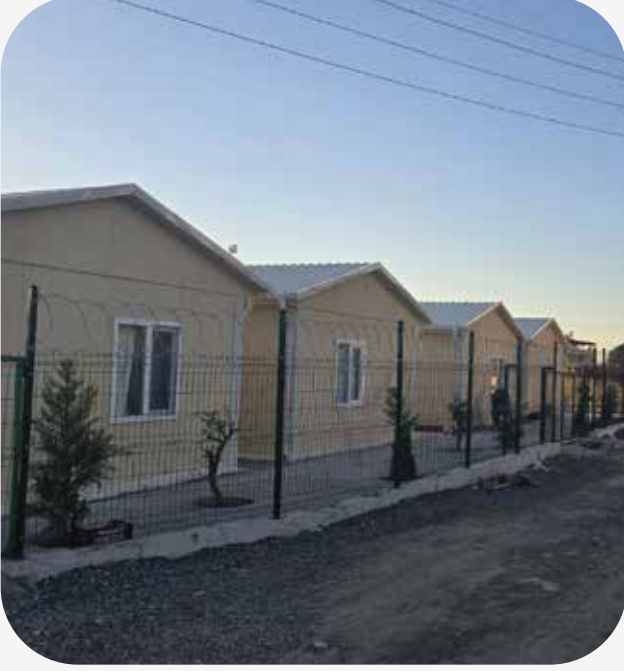
ARSUZ DEPREMZEDE KONUTLARI PROJESİ
