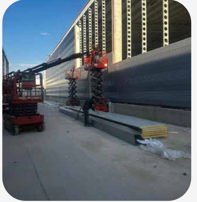
ORDU TEKSTİL FABRİKASI CEPHE VE ÇATI PANEL MONTAJI
